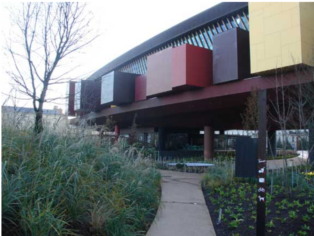
Musée du quai Branly. Fotografía: Xavier Roigé
